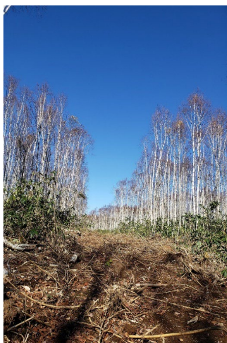
図 3 間伐後の表土戻し施工
